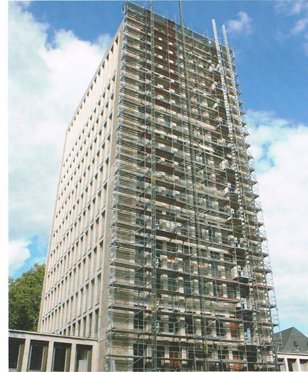
14 Einrüstung im Gerling Quartier
