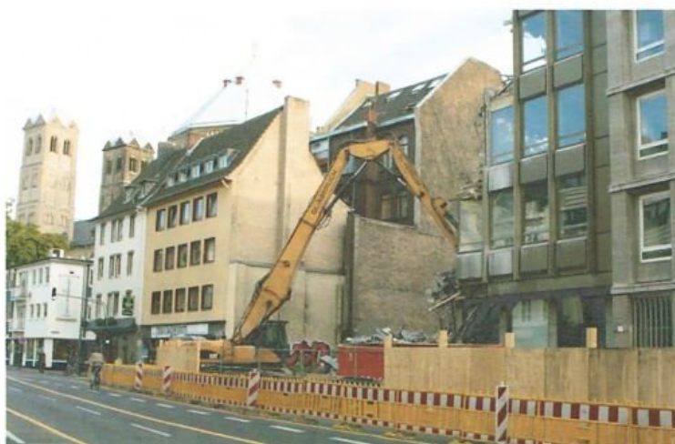
Abbrucharbeiten: Der Seitenflügel am ehemaligen Stadtarchiv Christoph-Str./Ecke Gereonskloster.
